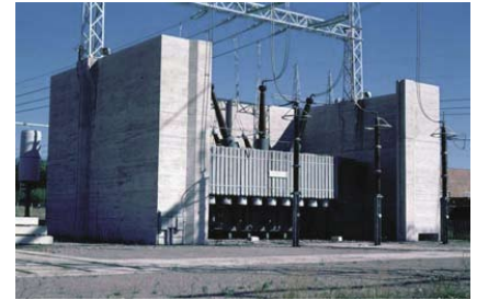
Die Onlinemessung der Ölfeuchte ist ein wichtiger Bestandteil von umfassenden Programmen zur vorbeugenden Wartung von Transformatoren.
