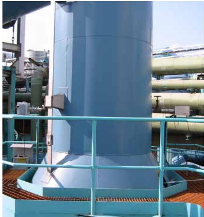
Cross-Stack-Messanordnung mit Sender und Empfänger
